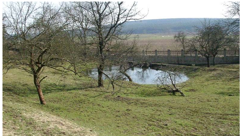
Abb. 55: zur Schneeschmelze füllt sich die vorhandene Mulde vor der Staumauer
